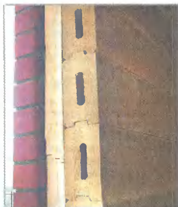
Устройство стены дома: брус — пенополистирол — кирпич
