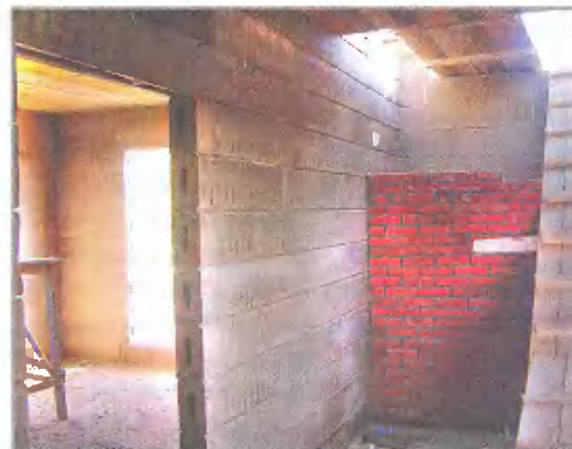
Несущие перегородки внутри дома возведены из того же строительного прессованного бруса, перевязанного с наружными стенами
