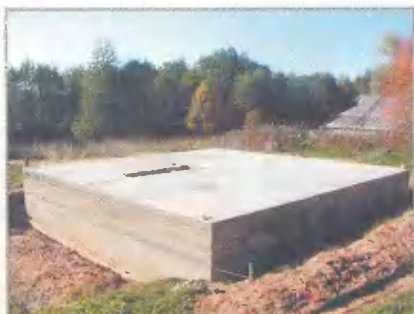
Заброшенный цокольный этаж в течение целого года выглядел, как памятник попытке возвести дом без проекта
