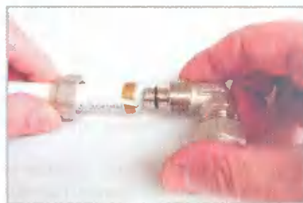
Накидную гайку и зажимное кольцо надевают на трубу перед калибровкой. Монтировать фитинг с трубой надо очень аккуратно, чтобы не повредить уплотнительное кольцо
