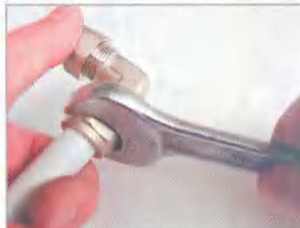
Навернуть накидную гайку на ниппель соединительной муфты и затянуть ее нужно при помощи соответствующего гаечного ключа
