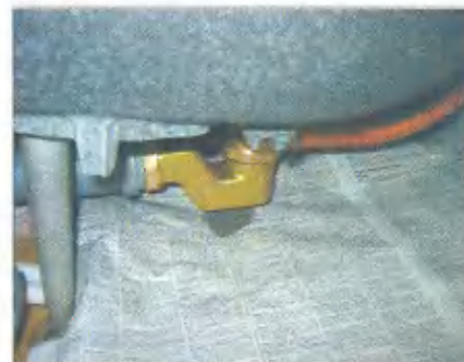
Пробный «запуск» системы не всегда бывает удачен. Выявить протечки воды поможет обычная газета, помещенная под проверяемый элемент конструкции
