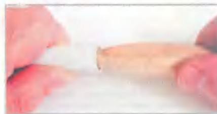
В качестве калибратора при монтаже металлопластиковых труб я использовал деревянную ручку от кисти
