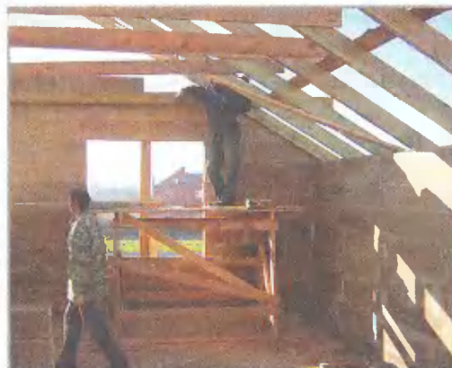
Высокая прочность материала стен позволяет обойтись без несущих перемычек в проемах и упрощает монтаж стропил
