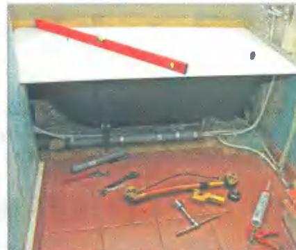
Ванна должна быть установлена строго горизонтально
